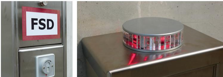
Abbildungen 2 a) + b): Erstanlaufstelle für die Feuerwehr mit FSD und FSE, häufig gekennzeichnet durch eine rote Blitzleuchte (Quelle: SFSG)
